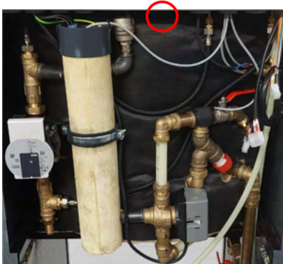
Placering af overkøgningsikring (Bund af el-skab)
