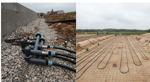
Güllekühlungsanlage im Bau
