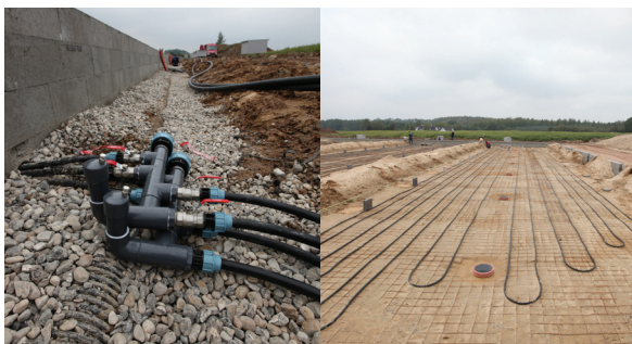
Gyllekølingsanlæg under opførelse
