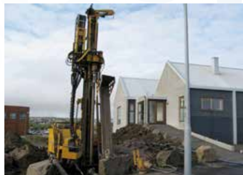
Figur 6.6. Etablering af lodrette borer.
