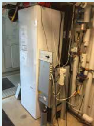
Figur 5.12. Væske/vand varmepumpe med vandrette jordslanger.
