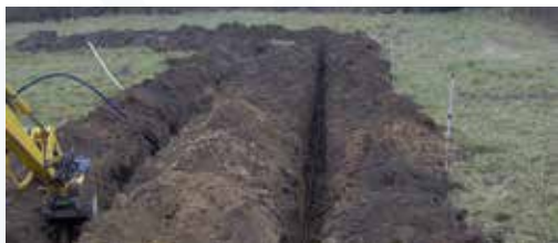
Figur 6.1. Etablering af vandrette jordslanger
